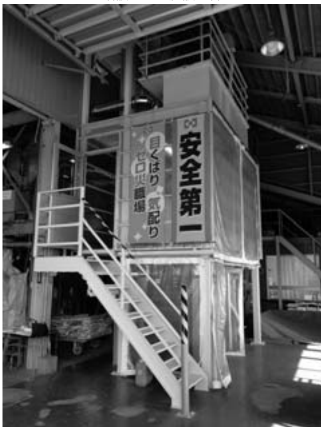
増設された施設全容
