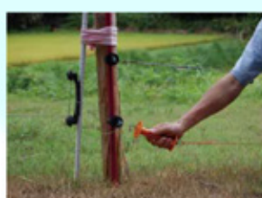
侵入防止柵の設置
